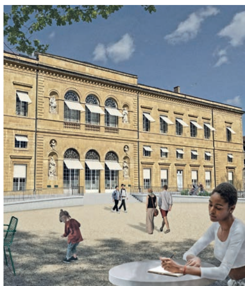
La future façade sud. CHABLAIS FISCHER
